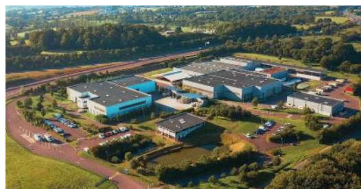
Pôle de valorisation de Cavigny - 2021
