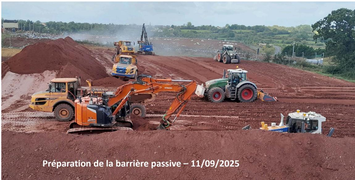
Les drains seront installés la semaine prochaine. La barrière passive vise à étancher le site. Un mètre d'argile est travaillé puis compacté à un taux de perméabilité de  $10^{-9}$ . Pour rappel, il y aura une période de post exploitation de 25 ans à compter de 2031.
