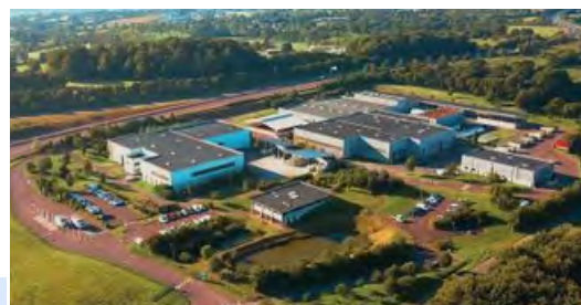
Pôle de valorisation de Cavigny - 2021
